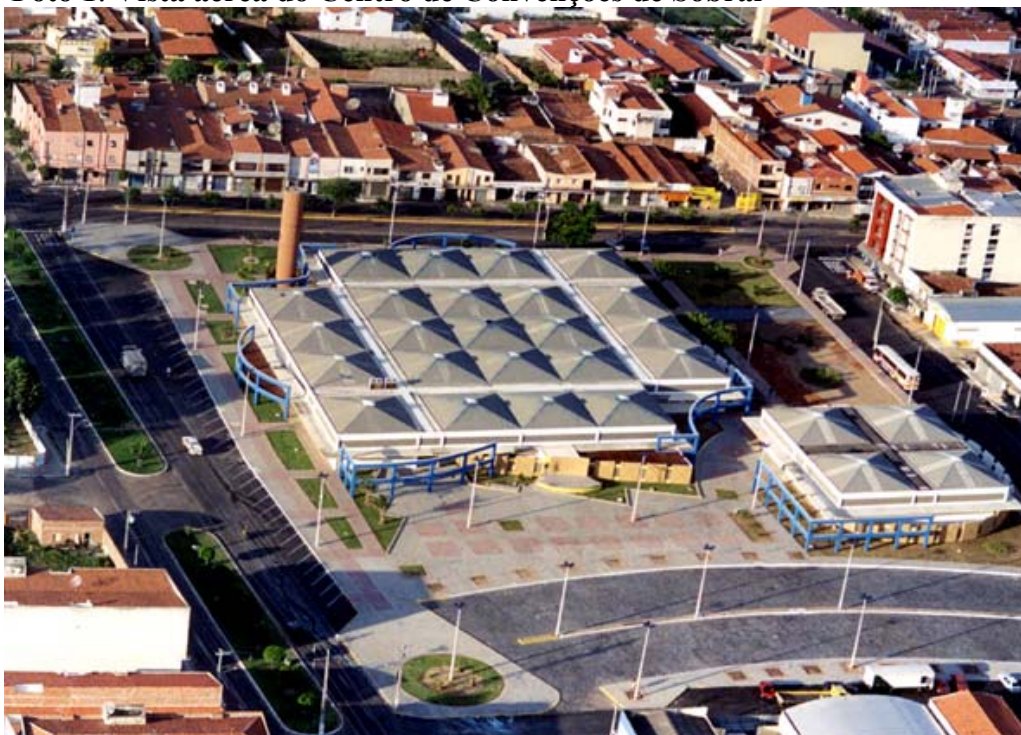
Foto 1: Vista aérea do Centro de Convenções de Sobral
